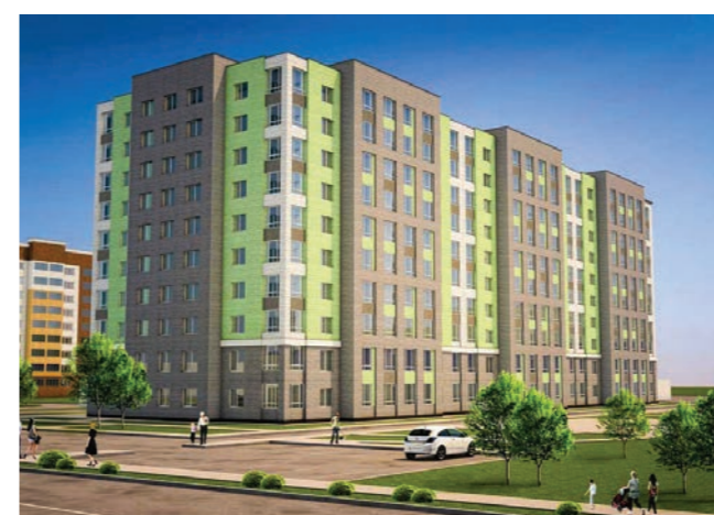
ЖК «Дом на Окском», г. Рязань ECO HOME
